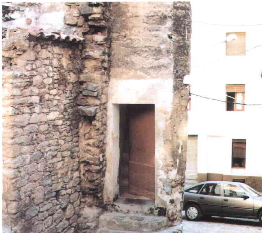
Rincón del casco antiguo actualmente en rehabilitación.
